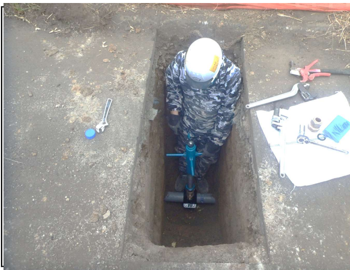
サドル分水栓取り付け
