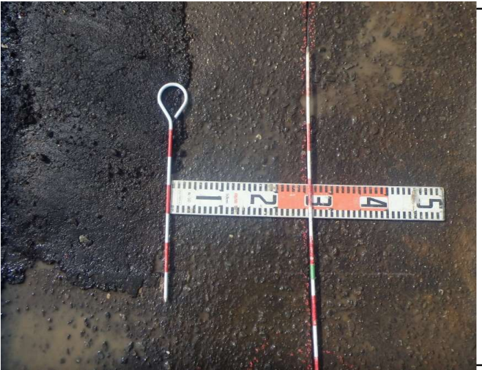
舗装影響幅測定
