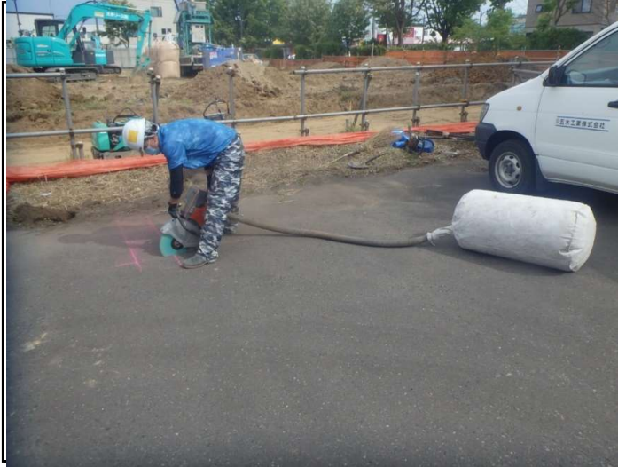
舗装切断状況
