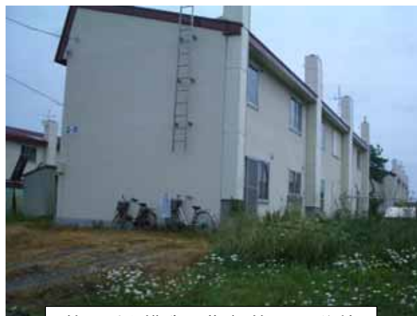
簡易耐火構造二階建(簡二)の住棟
