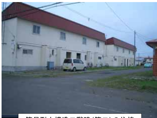
簡易耐火構造二階建(簡二)の住棟
