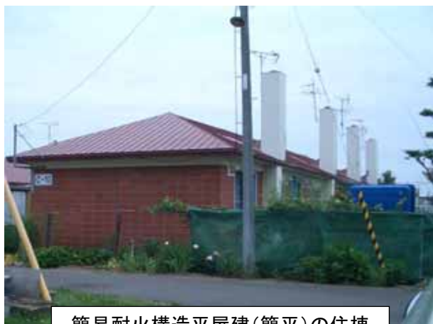
簡易耐火構造平屋建(簡平)の住棟
