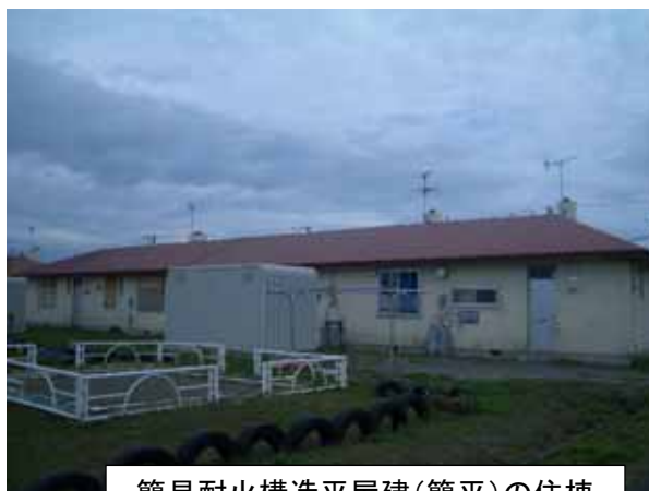
簡易耐火構造平屋建(簡平)の住棟
