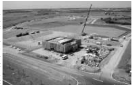
造成中の埋立処分地
