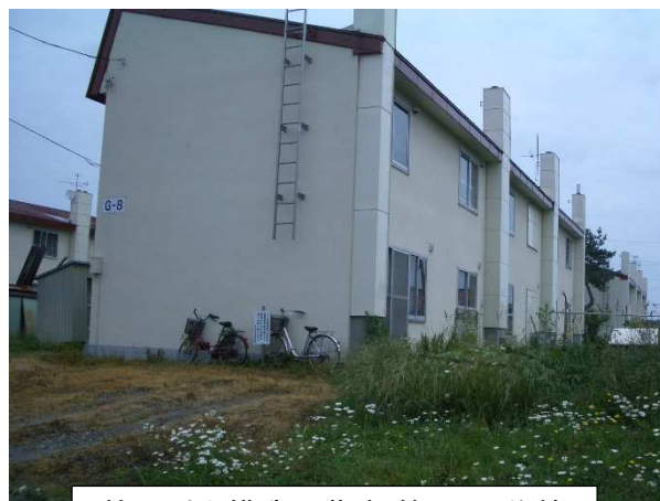
簡易耐火構造二階建(簡二)の住棟
