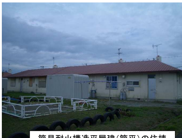
簡易耐火構造平屋建(簡平)の住棟
