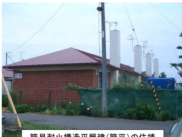
簡易耐火構造平屋建(簡平)の住棟
