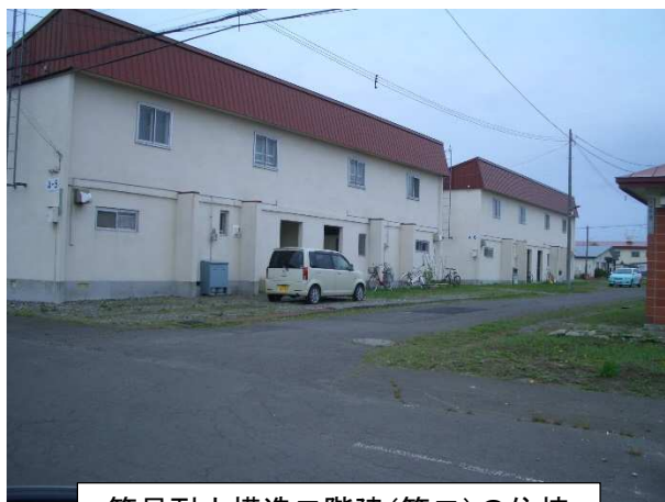
簡易耐火構造二階建(簡二)の住棟
