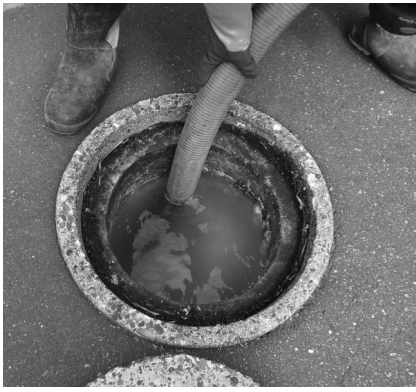
▲下水管の詰まりを処理している現場
