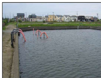
●原水を溜める施設
