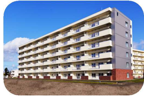
完成したD棟
