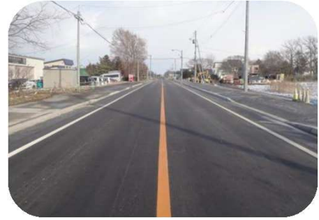
拡幅整備した兵村4番通り
