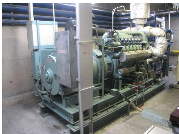
写真 7-13 【消化ガスを燃料とした発電装置】
