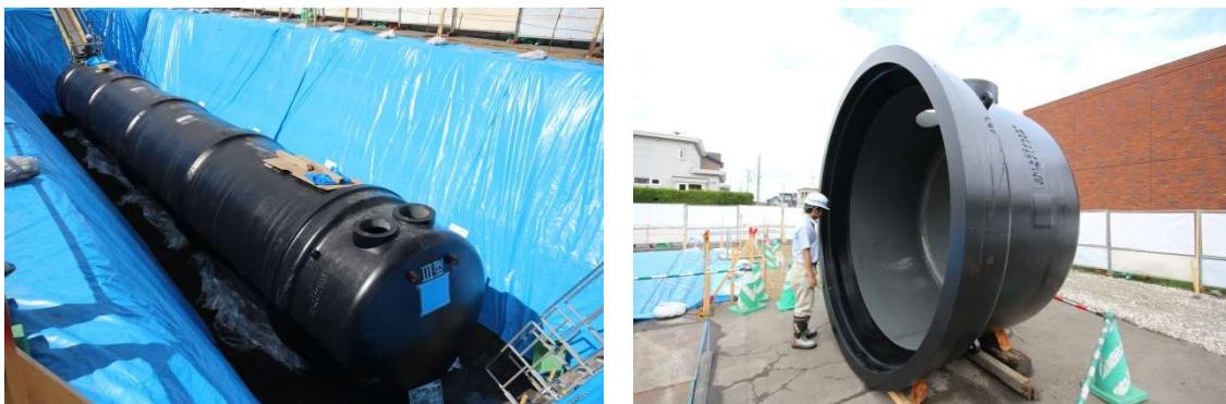
写真 7-7 [2017年度(平成29年度)に対雁小学校に設置した緊急貯水槽 100 m<sup>3</sup>級]
