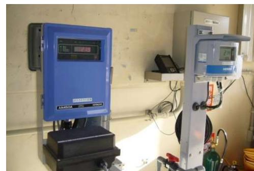
写真 7-1【水質連続監視装置(濁度計)】
