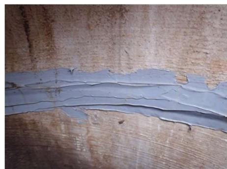
写真 7-5 【マンホール内継目補修状況】
