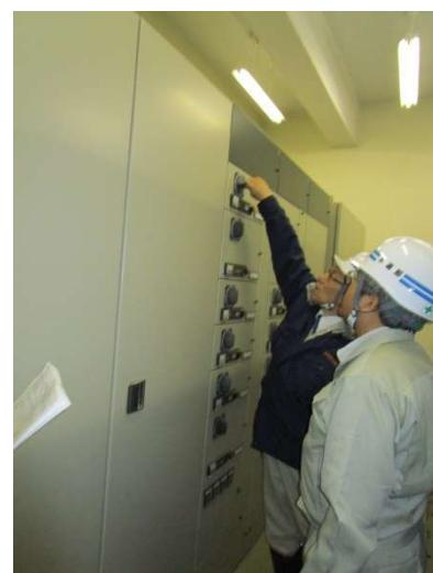
写真 5-4【機器制御盤の点検】
