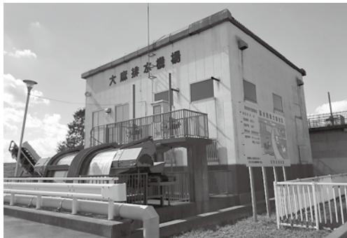
大麻排水機場
