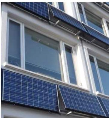
架台イニシャルコストにおいて、壁面設置は屋上設置に比べ、約2分の1のコストで製作可能でした。
