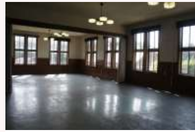
研修室1号 建設当時の状態が保存されていて、レトロ調のまま。未改修。
