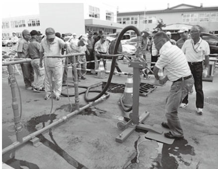
緊急貯水槽の応急給水訓練
