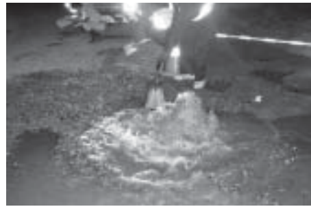
▲漏水が原因で地中から溢れる水道水
