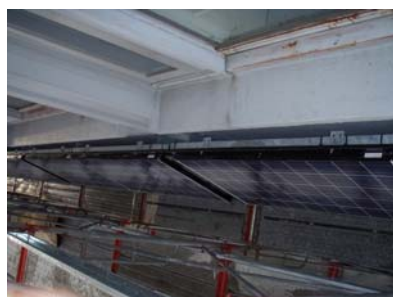
写真 - .1.10 パネルの設置
