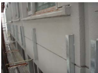
写真 - 2.1.9 架台の取付
