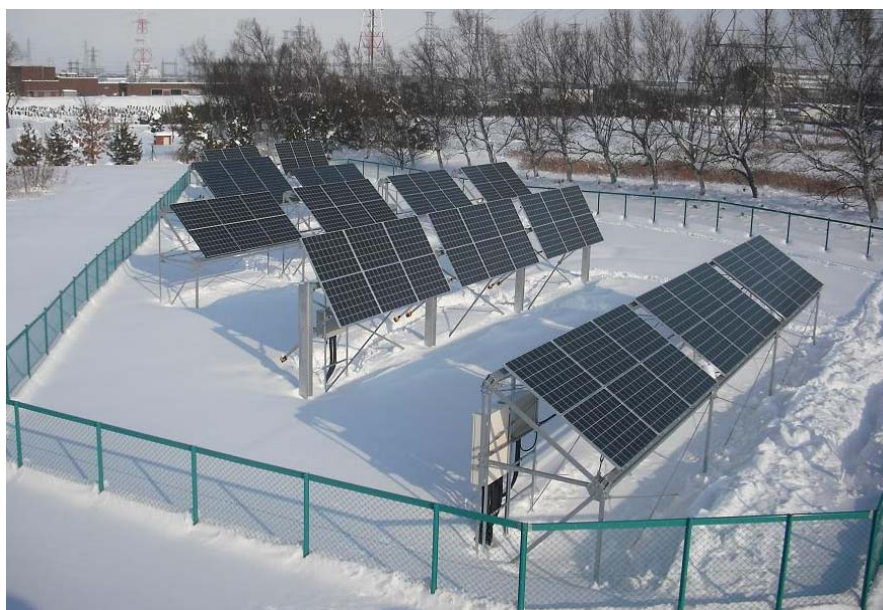
写真 - 3.1.1 1列目(写真右端): 固定架台、2列目: 可変架台
