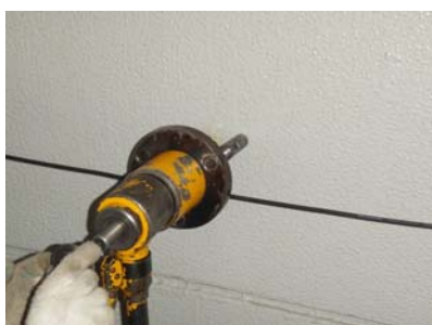
写真 - 2.1.7 アンカー引抜試験 ( 1 )
