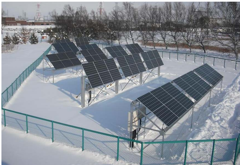
写真 - 4.1.1 落雪性能研究用の太陽光パネルの配置
