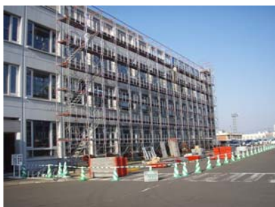
写真 - 2.1.5 外部足場設置(1)
