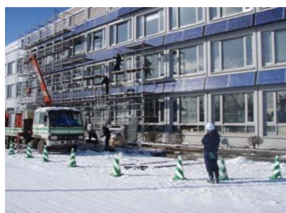
写真 - 2.1.11 足場解体
