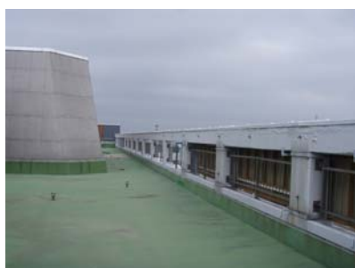
写真 - 2.1.3 市役所本庁舎屋上
