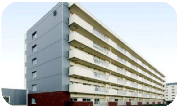
完成したB棟
