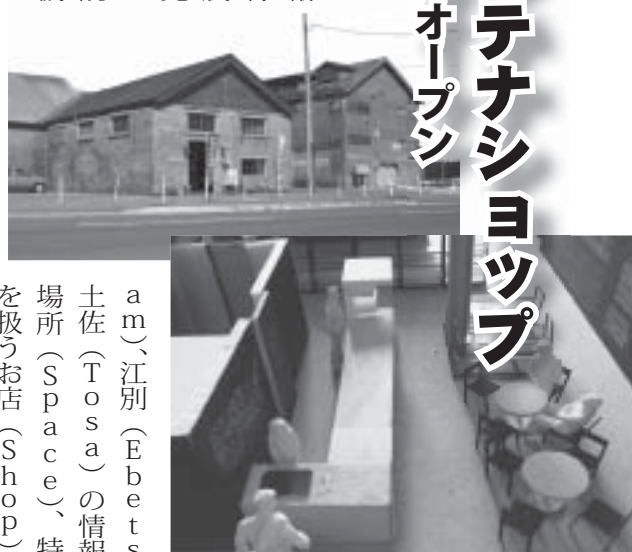
改修工事が進められている旧ヒダ工場(上)とアンテナショップの完成模型(下)
