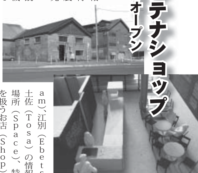
改修工が進められている旧ヒダ工場(上)とアンテナショップの完成模型(下)
