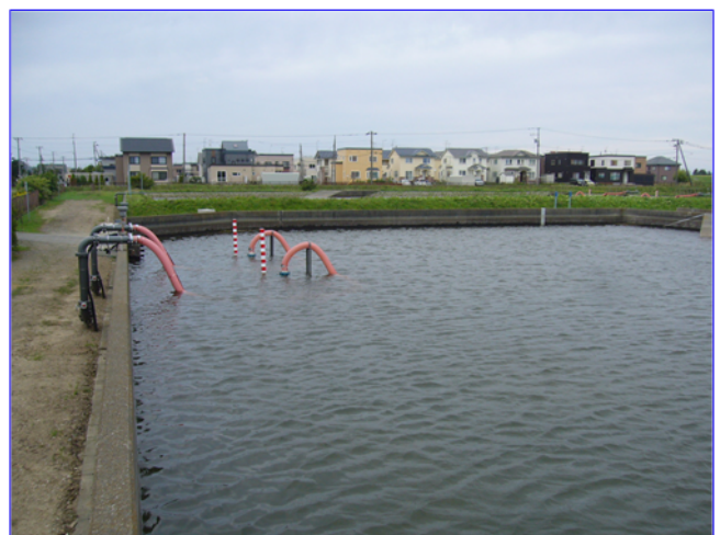
【天日乾燥床 原水貯留状況】
