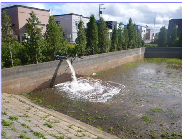
【天日乾燥床 原水投入状況】
