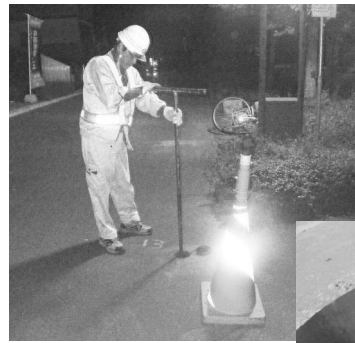
洗管作業の様子
