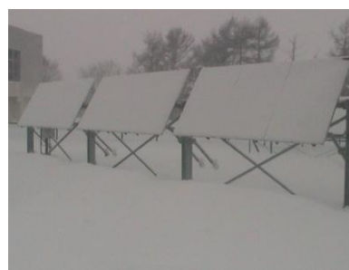
写真-2.2.1 固定架台と可変架台の積雪状況 (平成26年1月17日の当月最寒日正午前撮影)
