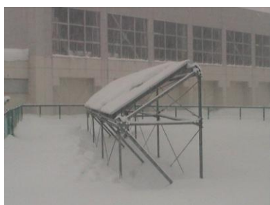
写真-2.2.1 固定架台と可変架台の積雪状況 (平成26年1月17日の当月最寒日正午前撮影)
