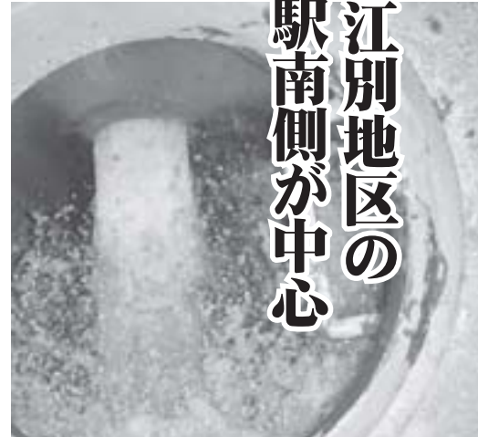
放水洗管の状況
