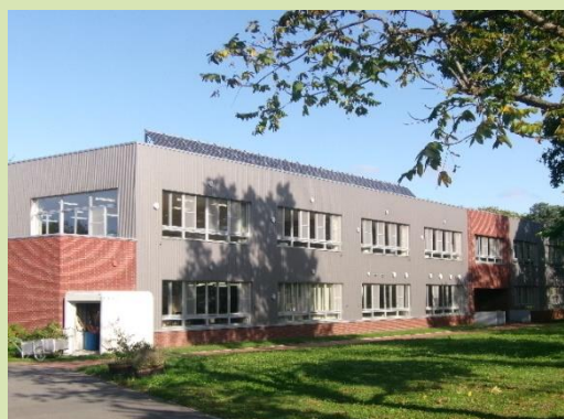
江別第二小学校の太陽光発電設備（約20kW）
