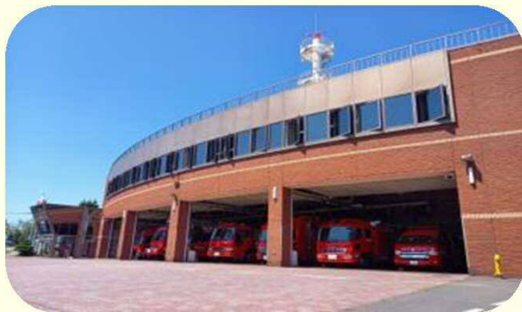
消防本部庁舎
