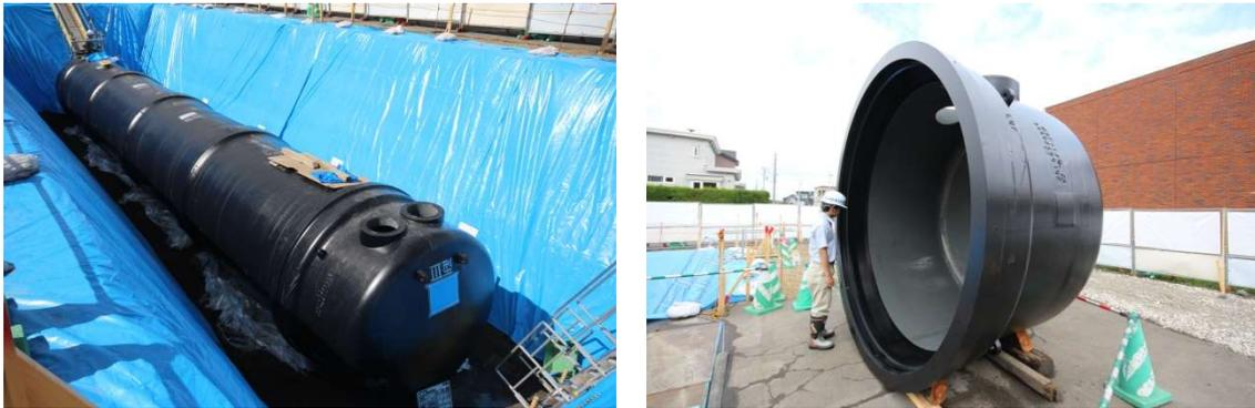
写真 7-7 【2017（平成 29）年度に対雁小学校に設置した緊急貯水槽 100 m級】
