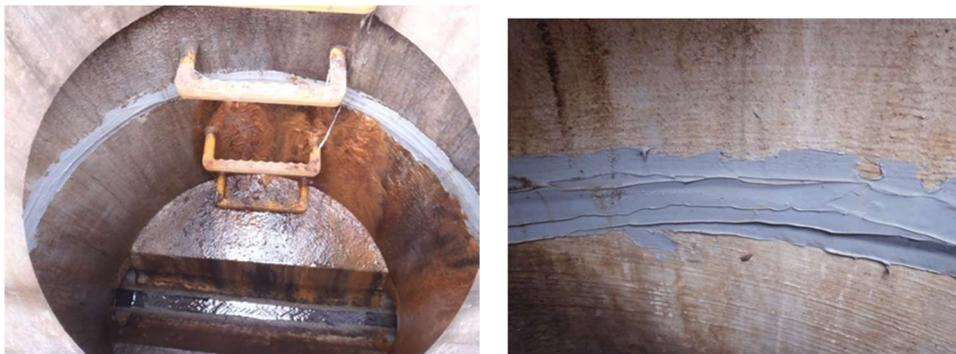
写真 7-5【マンホール内継目補修状況】
