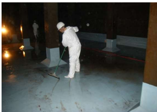
写真 7-3【配水池内部の清掃】
