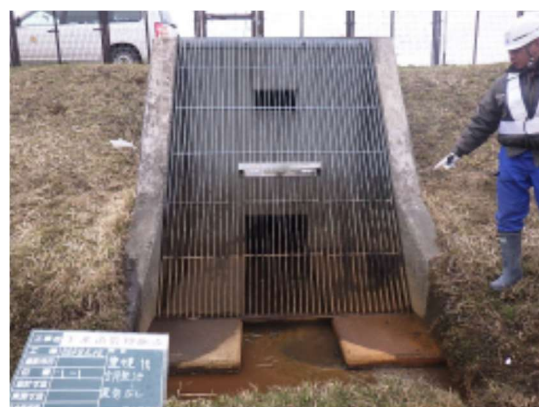
写真 7-9【雨水設備点検状況】
