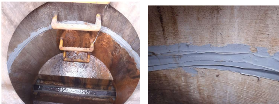
写真 7-5【マンホール内継目補修状況】
