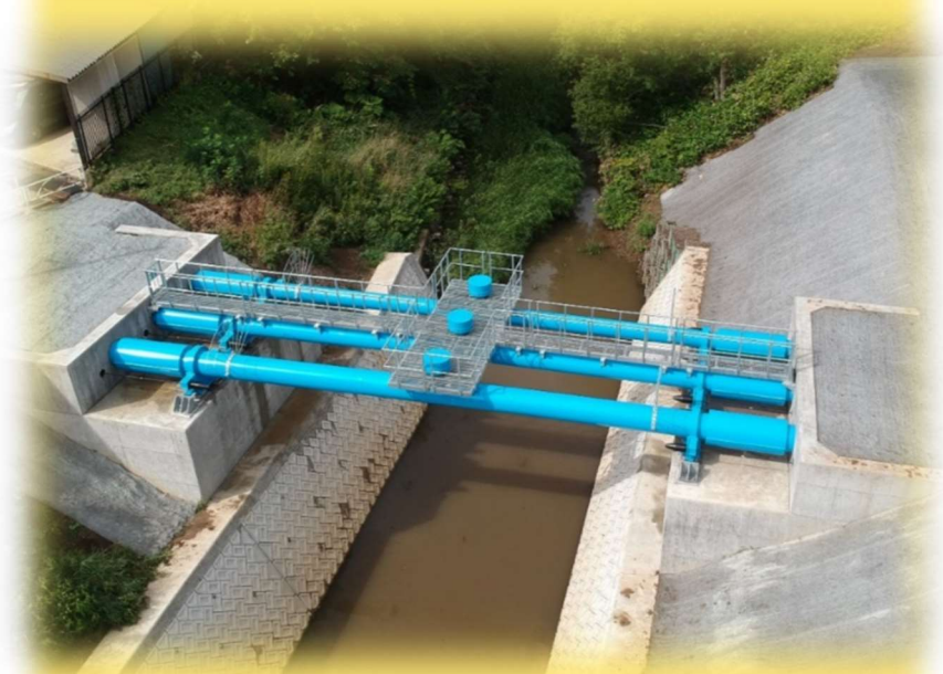
早苗別水管橋(令和3年度架替完成)
