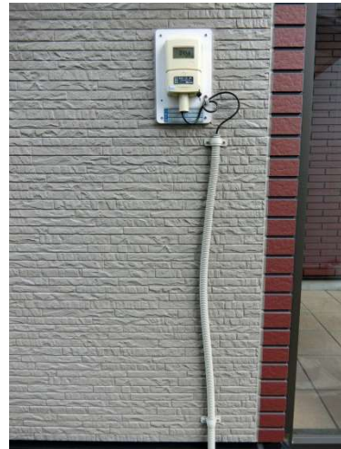
写真 3-13【電子式メータ】
