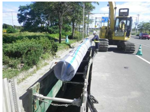
写真 5-2 【管路の耐震化工事】
