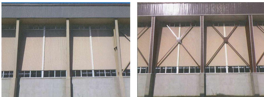
写真 7-6 【合流系池棟の耐震化 対策前（左）補強部材設置後（右）】
