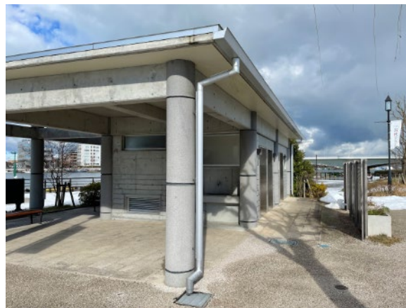
休息スペースとして 広い屋根が設けられた公衆トイレ ※より快適に過ごせる空間として整備したいと市民の要望もあったが、元々公衆トイレとしての目的で用地を確保してしまったため実現には至らなかったという
