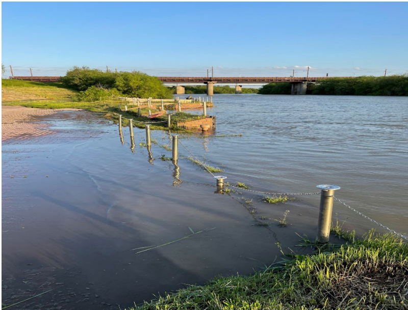
増水時の河川防災ステーション 船着場の様子
