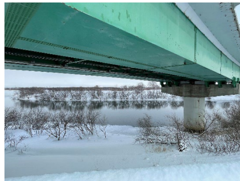
②新江別橋の橋梁下(係留区域の案)
