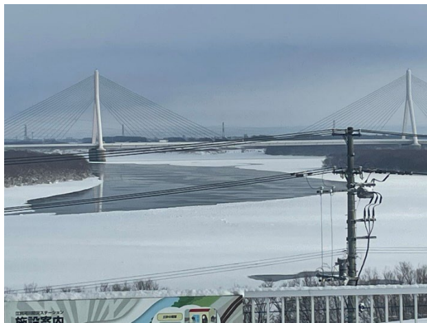
一部が凍結した石狩川
