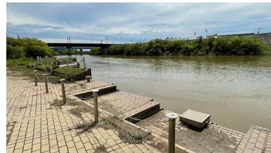
現状の 江別 河川防災ステーションの船着場
