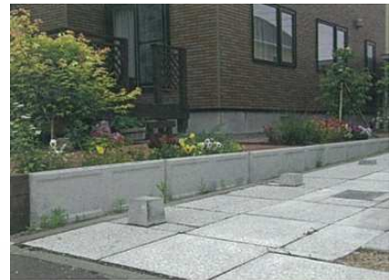
▲玄関先花壇工事
