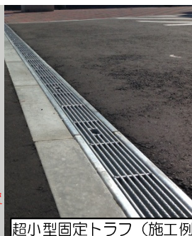
超小型固定トラフ (施工例)
