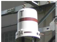
高圧自動開閉器用低圧子局装置
