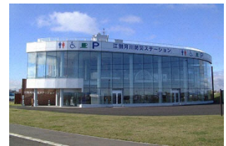
河川防災ステーション
