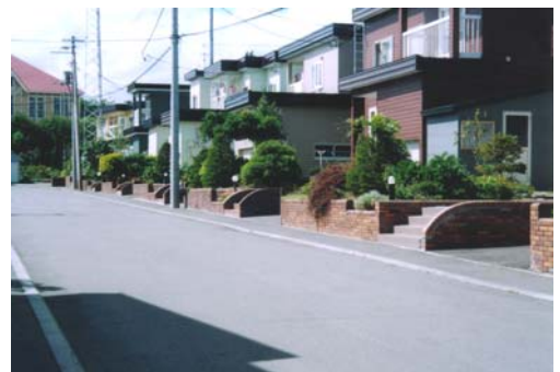
統一感のある住宅街の街並み～野幌若葉町
