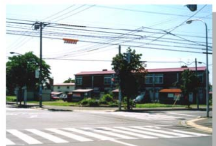
改善したい景観～交差点の電線
