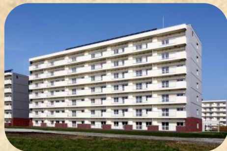
完成したE棟
