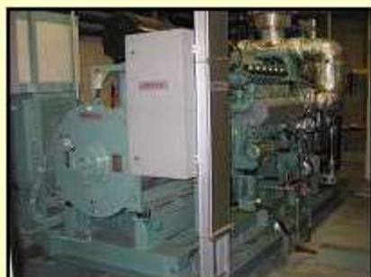
(消化ガスエンジン発電機)
