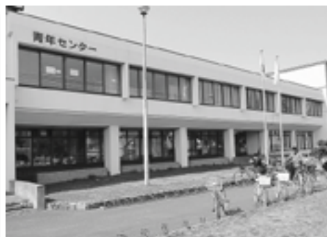
昭和47年建築の青年センター
