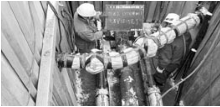
水道配管工事の様子
