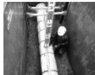
▲ 基幹管路耐震化事業
