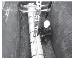
▲ 基幹管路耐震化事業
