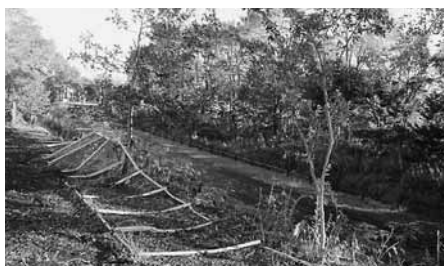
四季のみちの倒壊フェンス
