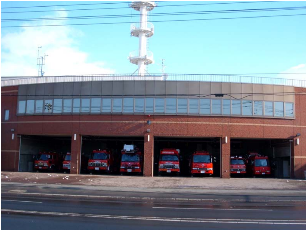
消 防 本 部 庁 舎
