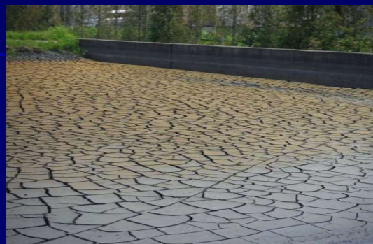
天日乾燥床の汚泥
