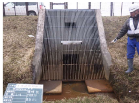
写真 7-9【雨水設備点検状況】
