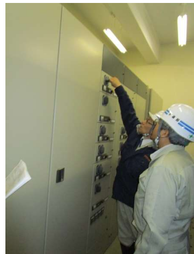
写真 5-4【機器制御盤の点検】
