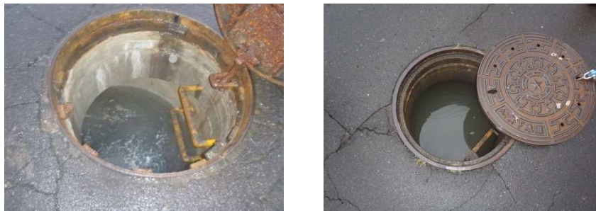
写真 3-9【污水管が不明水により浸った状況】
