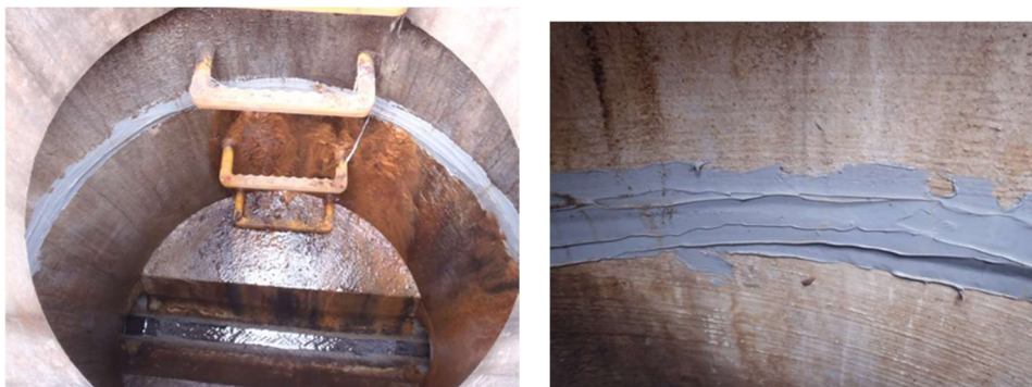
写真 7-5【マンホール内継目補修状況】
