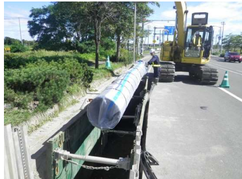
写真 5-2【管路の耐震化工事】
