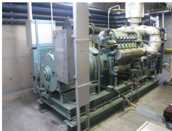
写真 7-13 【消化ガスを燃料とした発電装置】
