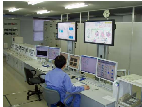
写真 7-4【配水状態の監視】
