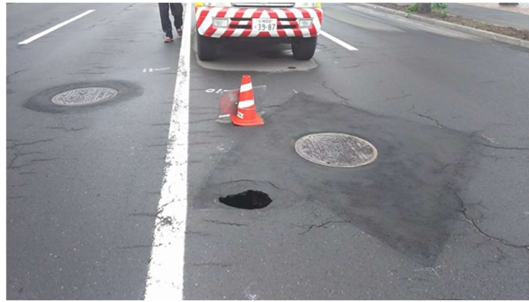
写真 3-3 【市内で発生した陥没状況】
