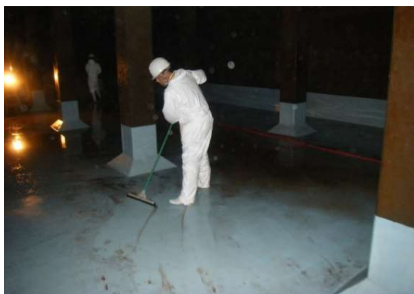
写真 7-3【配水池内部の清掃】
