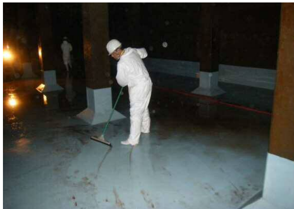
写真 7-3【配水池内部の清掃】
