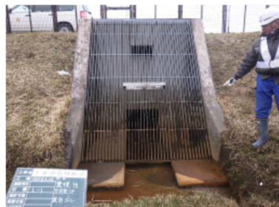
写真 7-9【雨水設備点検状況】
