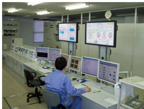
写真 7-4 【配水状態の監視】
