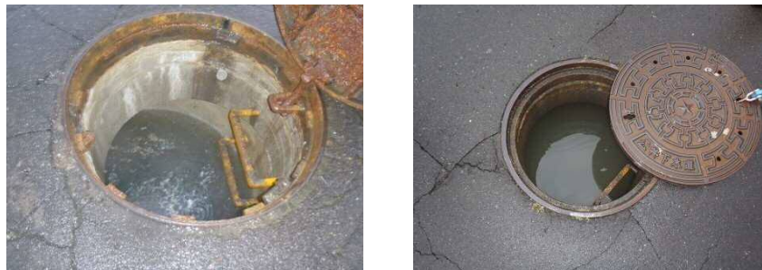
写真 3-9【污水管が不明水により浸った状況】
