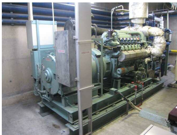
写真 7-13 【消化ガスを燃料とした発電装置】
