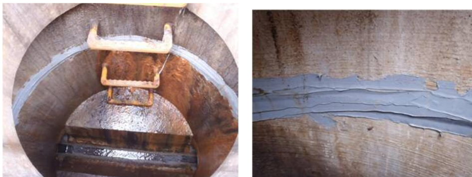
写真 7-5 【マンホール内継目補修状況】
