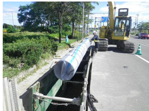
写真 5-2【管路の耐震化工事】
