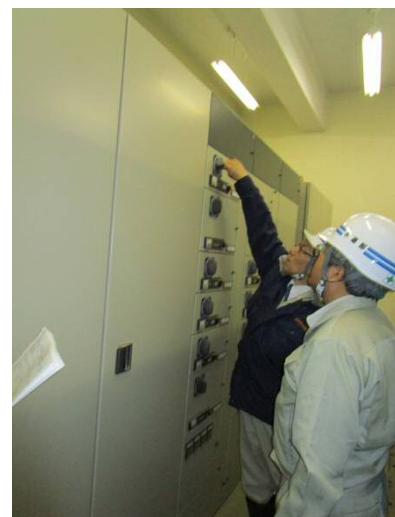
写真 5-4【機器制御盤の点検】
