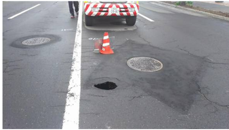
写真 3-3 【市内で発生した陥没状況】
