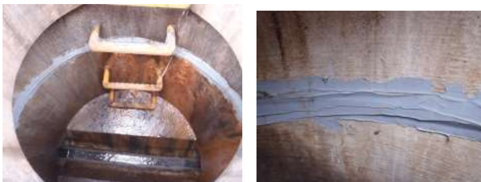
写真 7-5【マンホール内継目補修状況】
