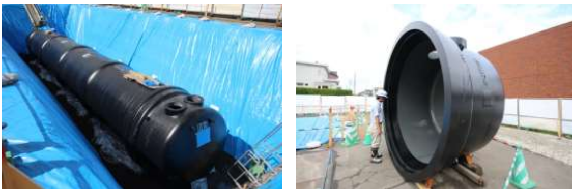
写真 7-7 【2017年度(平成29年度)に対雁小学校に設置した緊急貯水槽 100 m 3 級】
