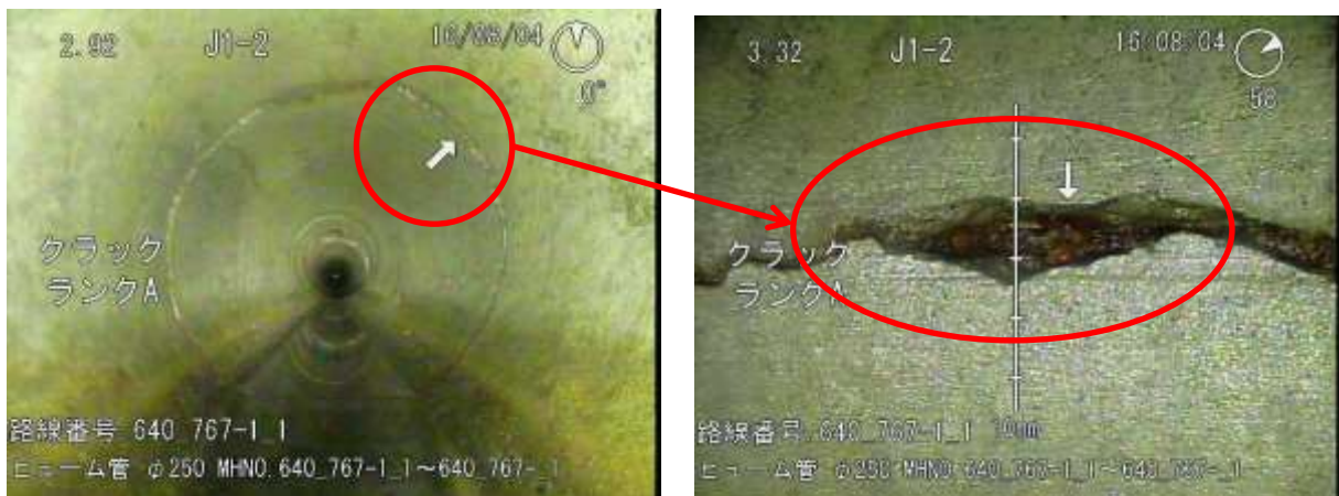
写真 3-4 【管路内破損状況】
