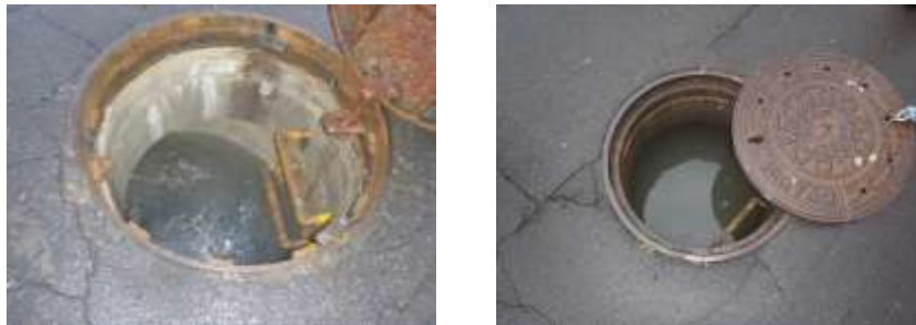
写真 3-9【污水管が不明水により浸った状況】
