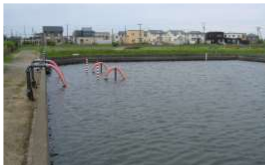
写真 7-2【原水を貯める施設 原水投入状況(左)、原水貯留状況(右)】
