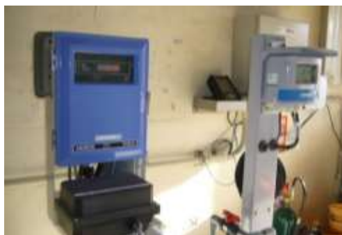
写真 7-1【水質連続監視装置(濁度計)】
