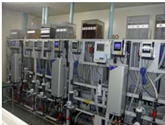
写真 3-6【水質監視計器】
