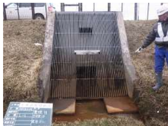
写真 7-9【雨水設備点検状況】
