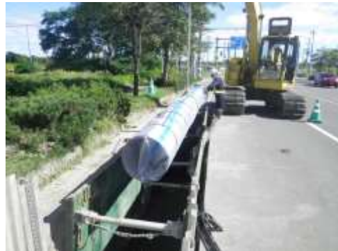
写真 5-2【管路の耐震化工事】
