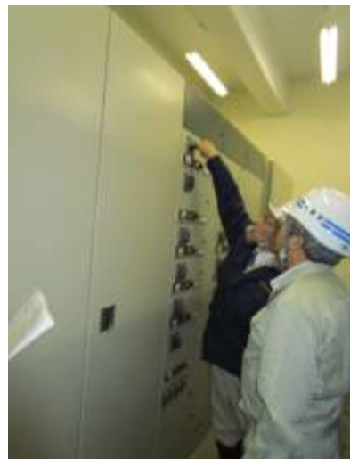
写真 5-4【機器制御盤の点検】
