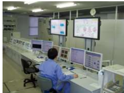
写真 7-4【配水状態の監視】
