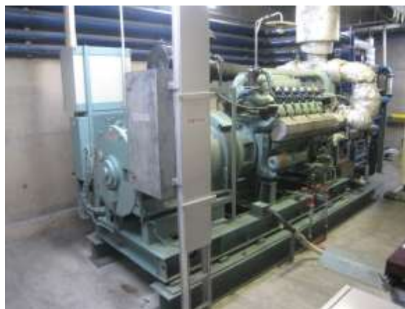
写真 7-13 【消化ガスを燃料とした発電装置】
