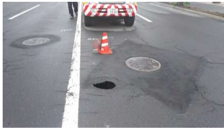
写真 3-3 【市内で発生した陥没状況】
