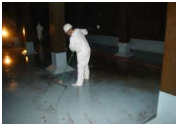
写真 7-3【配水池内部の清掃】
