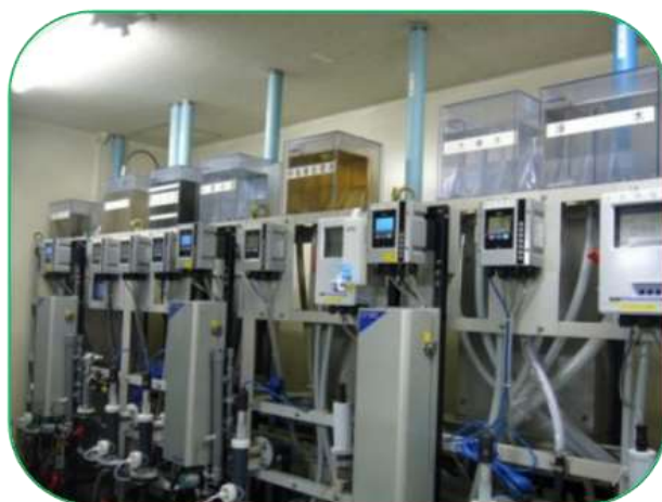
写真 3-2 【水質監視計器】
