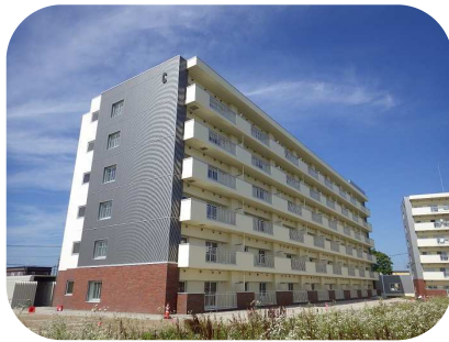
完成したC棟
