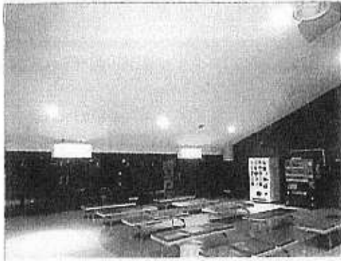
【ラウンジのLED照明】
