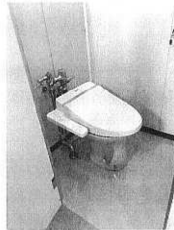
(各館で改修継続中のトイレ洋式化)
