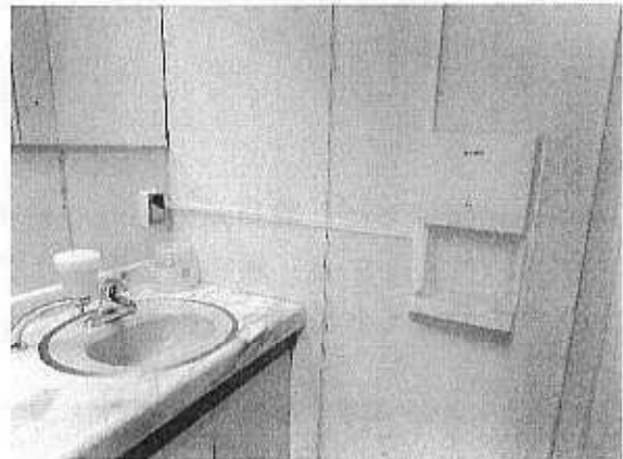
(各館のトイレに設置した温風乾燥機)
