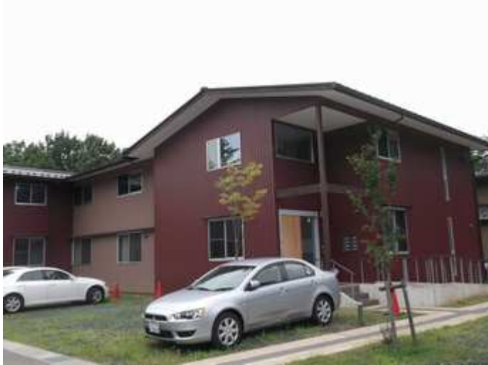
サービス付き高齢者向け住宅 (2階建て)
