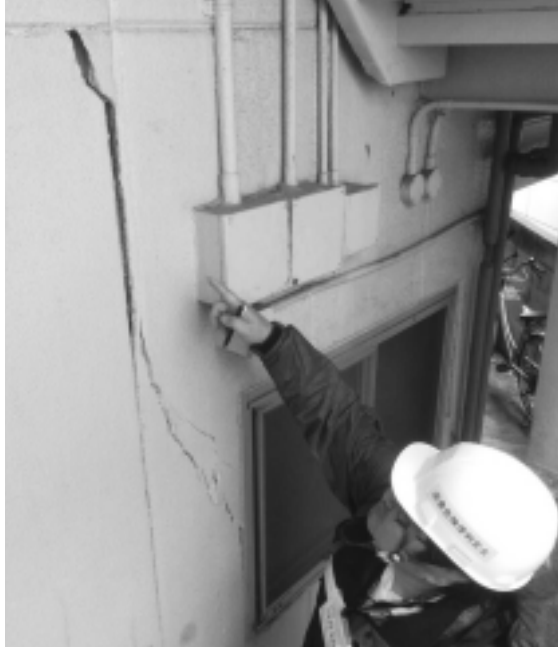
写真右／左の家屋は、地震で損壊して寄りかかった右側の空き家の重さに耐えているが、落下物などの危険により、危険状態と判定。写真左／アパートの壁に入った大きな亀裂を確認（いずれも熊本市内）
