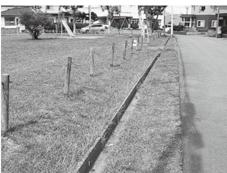
公園周囲の側溝
