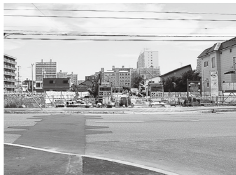
8丁目通り延伸部分
